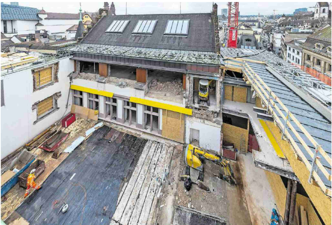
Blick in den Innenhof. Das Dach, auf dem der Bagger steht, war gestern Abend bereits bis auf die Stahlträger abgetragen. Bilder: Kenneth Nars
