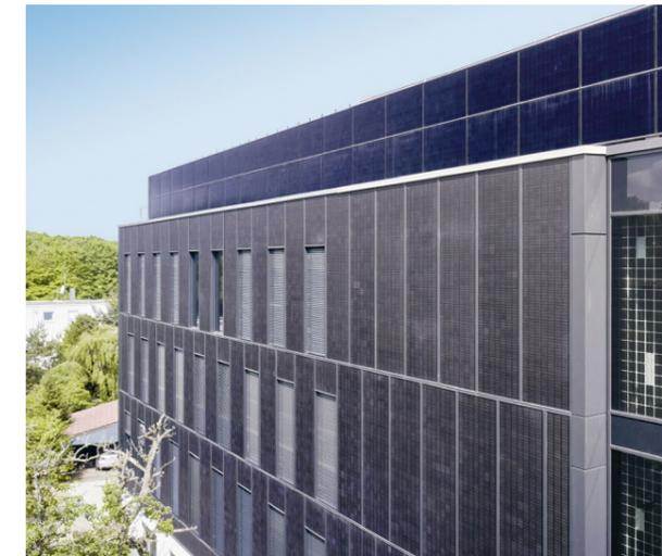
Außerdem ist das innovative Fassadensystem nach der Brand-schutz-Klassifizierung auch für den Einsatz im Hochhausbau geeignet – bestätigt durch die Materialprüfanstalt für das Bauwesen der TU Braunschweig und durch die Erteilung der allgemeinen bauaufsichtlichen Zulassung (abZ).
