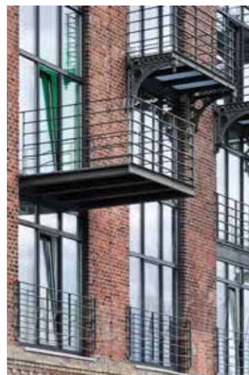
Abb. 25 Balkone verschiedener Tiefen ergänzen die Regelmäßigkeit der Fassade.
