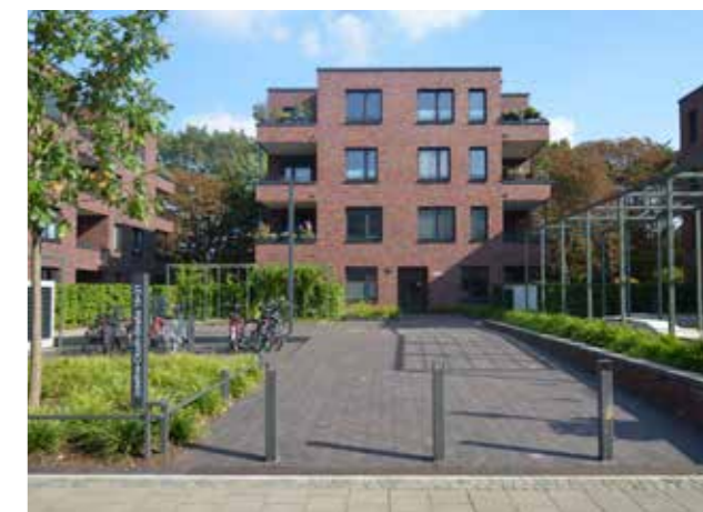
Abb. 40 Der Innenhof des Aktiven Hofes räumt den Bewohnern Grünbereiche als Rückzugsräume ein. Zusätzlich ermöglichen Fahrradabstellplätze und Spielmöglichkeiten für Kinder Gespräche zwischen Nachbarn.
