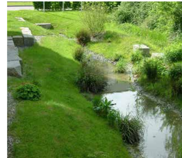
Abb. 38 Grüne, leicht vertiefte Regenwassermulden fangen den Niederschlag auf und entlasten das städtische Wassersystem.
