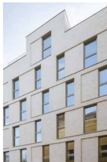
Abb. 20 Wechselnde Positionierung der Fenster innerhalb der Fassade.
