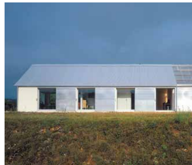
Abb. 15 Die Hallen bleiben in ihrer baulichen Form erhalten. Der Einsatz industrieller Materialien greift die ursprüngliche Nutzung auf.
