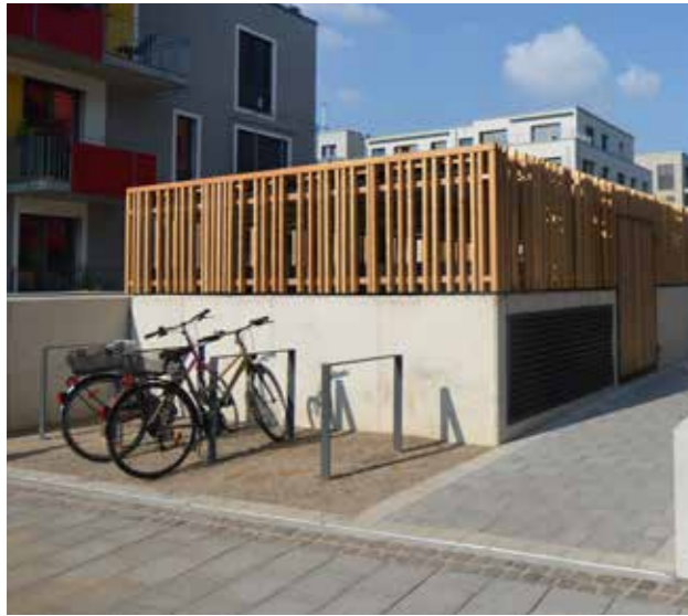
Abb. 92 Müllabstellflächen und/oder andere infrastrukturelle Einbauten können, insofern sie nicht in den Erdgeschosszonen der Häuser integriert werden können, materialbewusst in die Außenraumgestaltung einbezogen werden.
