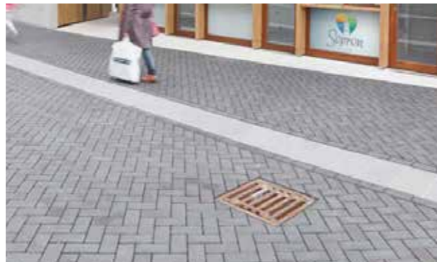
Abb. 32 Gängige Steinformate können durch das Verlegemuster sowie die gezielte Ergänzung hochwertiger Bodenbeläge einen gestaltvollen Charakter annehmen.
