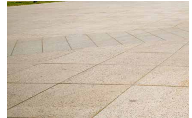
Abb. 98 Durch einen Wechsel in der Verlegerichtung können einzelne Zonierungen auf den großen Flächen ausgebildet werden.
