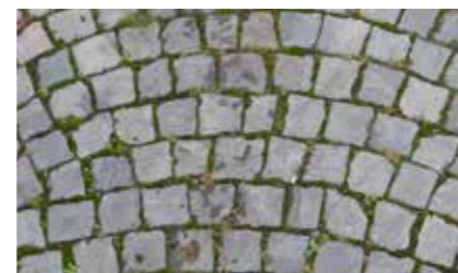
3) Das Basaltpflaster wird auch im neuen Quartier eine elementare Rolle spielen.
