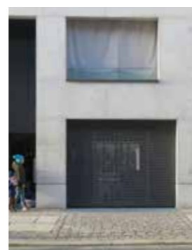
Abb. 2 Die Tiefgarageneinfahrt ist in die Sockelzone integriert.
