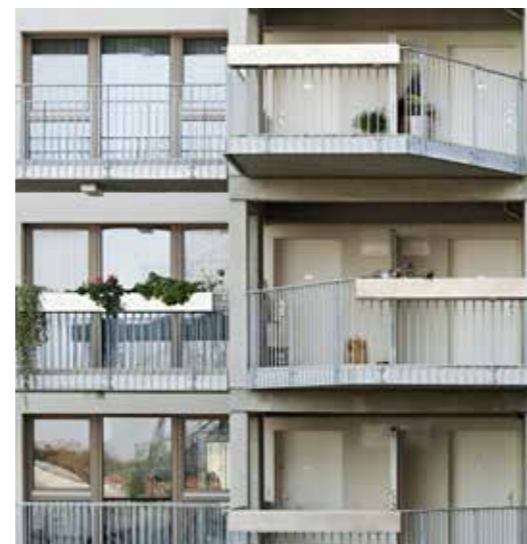
Abb. 21 Loggien und Balkone mit wechselnder Geometrie lockern das Fassadenbild auf.
