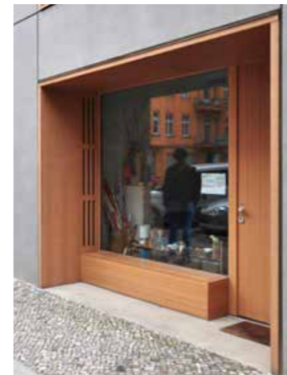
Abb. 12 Die tiefe Laibung des Eingangs öffnet sich zum Hof und wird zum urbanen Möbel.
