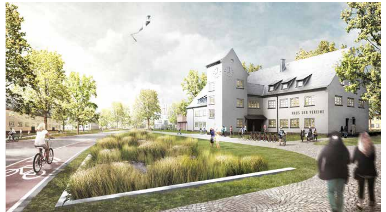
Zentrale Retentions- und Sickermulde entlang des zentralen Boulevards in trockener Phase
