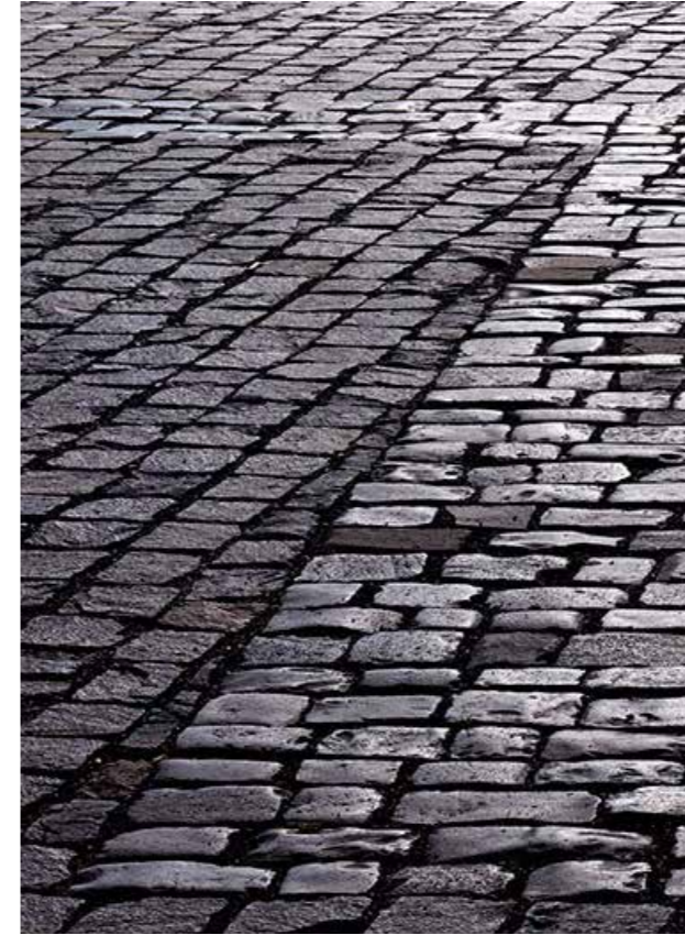
Abb. 71 Durch einen Wechsel in der Verlegerichtung können einzelne Zonierungen auf dem großen Flächen ausgebildet werden.
