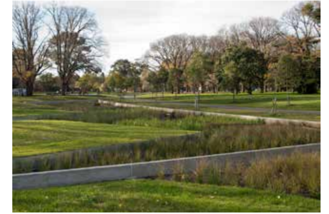
Abb. 72 Höhenversprünge und historische Bezüge sollten aufgenommen werden und in die Gestaltung der Mulden einfließen.
