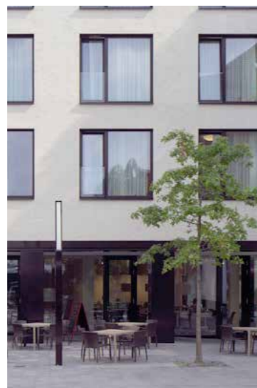
Abb. 77 Die Sockelzone setzt sich mit einem transparenten Erdgeschossbereich ab.
