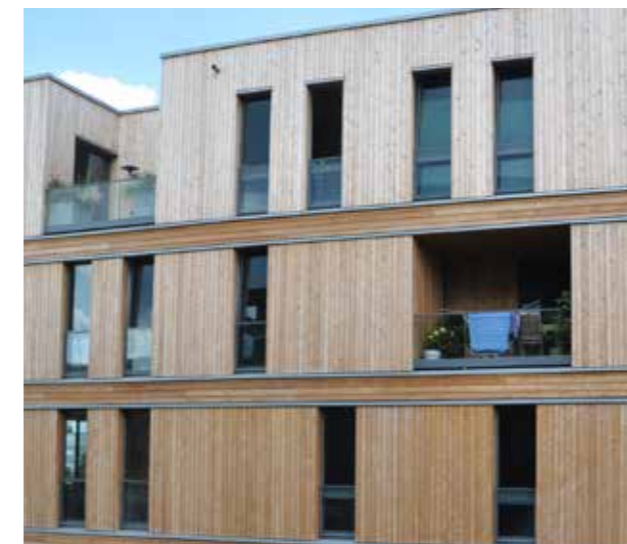
Abb. 64 Loggien, Dachterrassen und französische Fenster im Wechselspiel.
