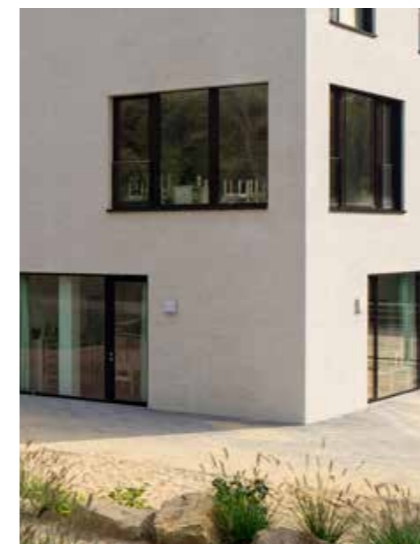
Abb. 22 Die Gebäudekante wirkt raumbildend. Die Fassade bildet eine Einheit mit dem Bodenbelag.
