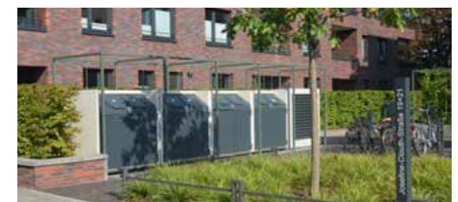
Abb. 102 Zentrale Müllsammelstellen sollten, insofern sie nicht in den Erdgeschosszonen der Häuser oder in Unterfluranlagen untergebracht werden können, harmonisch in die Außenraumgestaltung eingebunden werden.
