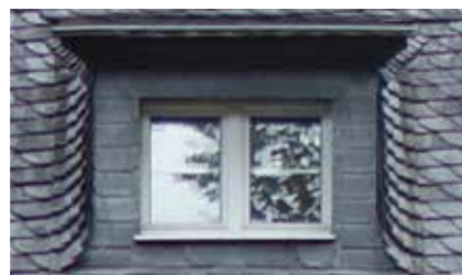
2) Das alte Schieferdach: unterschiedliche Farbfacetten der Schindeln
