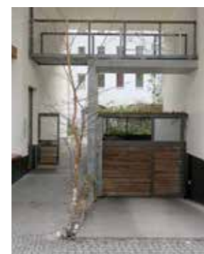
Abb. 1 Eine Tiefgarageneinfahrt in einer überbauten Durchfahrt.
