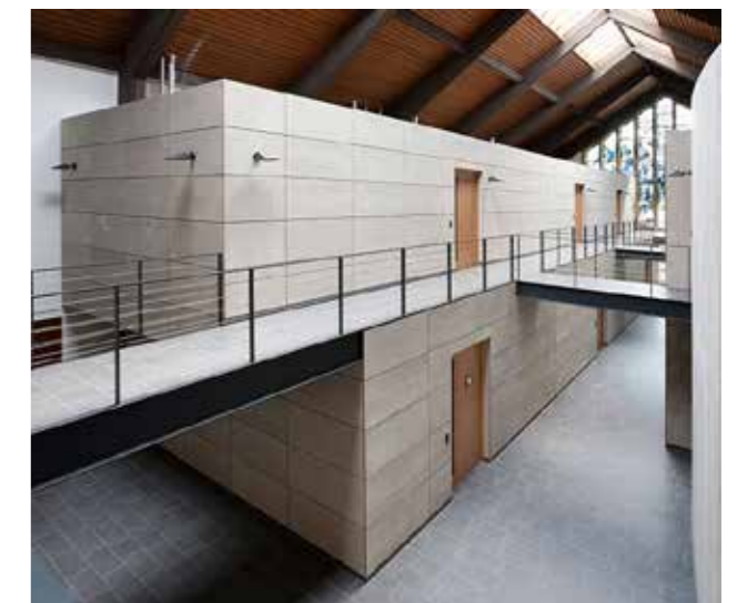
Abb. 18 Die massive bestehende Hülle erlaubt ein Haus-in-Haus-Prinzip. Vor- und Rücksprünge erzeugen abwechslungsreiche Zonierungen.
