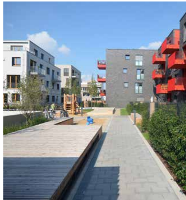
Abb. 53 Holzdecks, wechselnde Materialien sowie Zonierungen schaffen eine vielseitige Innenhoflandschaft.
